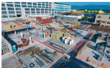
Projekt Spark, Beginn der Rohbauarbeiten, Anfang 2021
